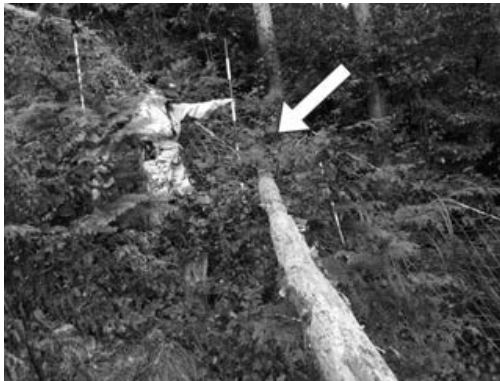
写真-1 倒木による柵体の破損（矢印）
