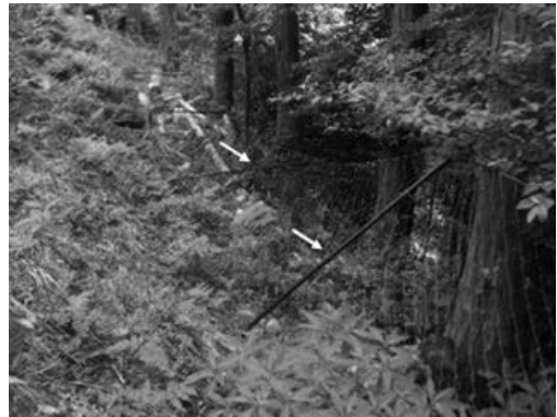
写真-2 雪害による支柱の折損（矢印）
