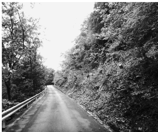
写真-2 倒木対策事業地の例（施工後）
