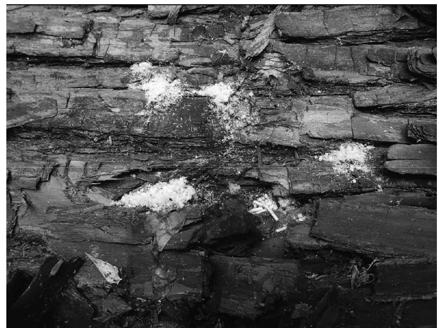
写真－2 害虫が原木に穿入した痕跡
