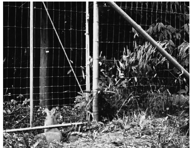
写真-6 扉部分の下にある隙間を通り抜けるノウサギ
