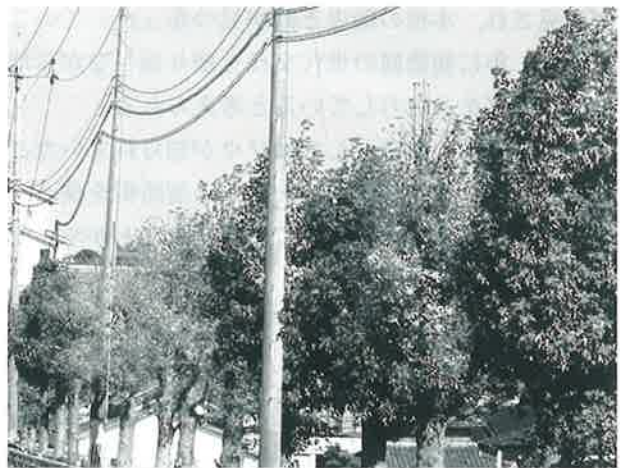
写真-1 長崎県の被害状況(国道207号線沿線)
