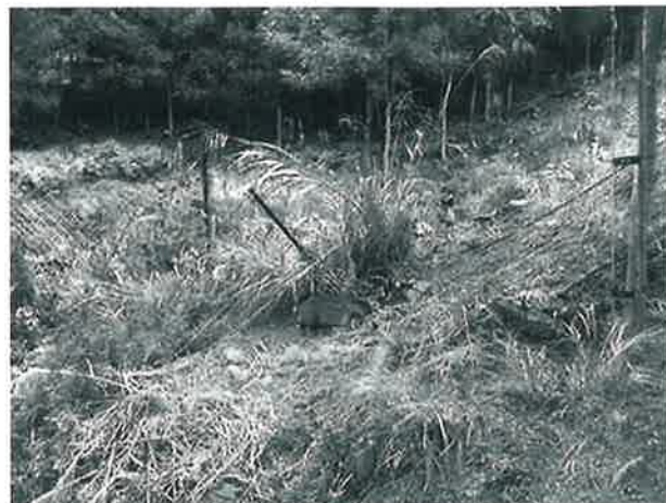
写真-3 獣害による防護柵の破損
