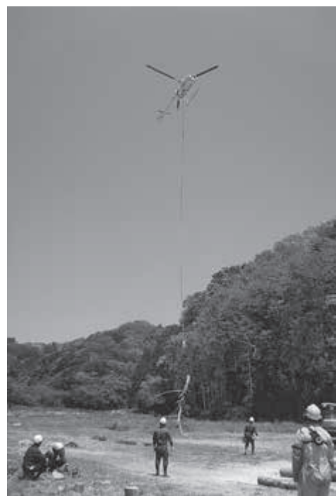
写真 ヘリコプターによる被害材搬出状況
