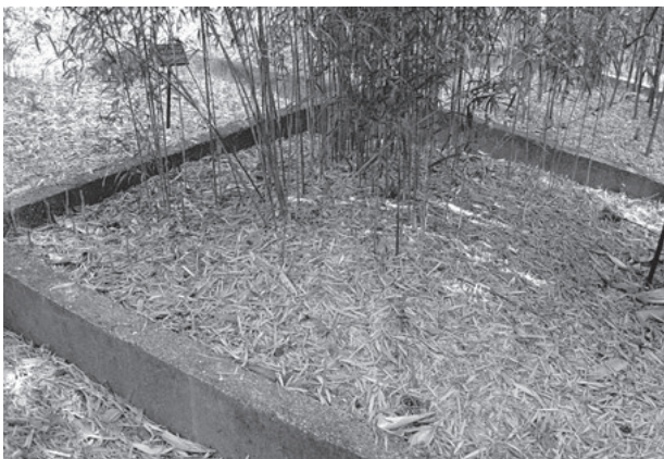
写真-10 地下茎の伸長を阻止するコンクリート壁
