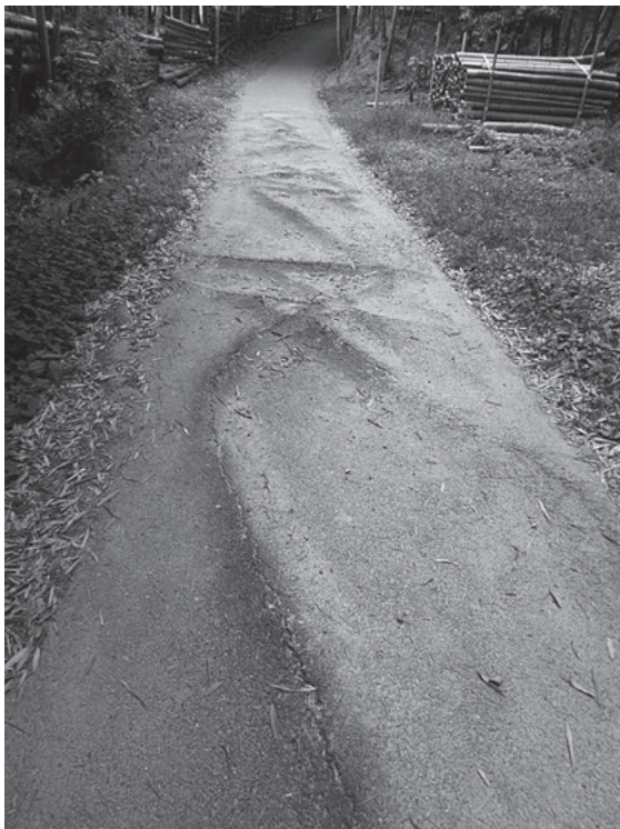
写真-1 タケの地下茎の伸長によって凸凹になったアスファルト舗装
