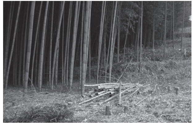
写真-4 耕作地に侵入したタケを伐採した現場
