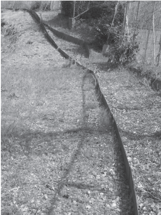
写真-9 地下茎の伸長を阻止する遮蔽板
