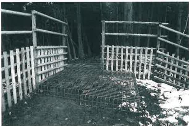
写真-7 事業地における金網マット設置状況 (2010年3月)
