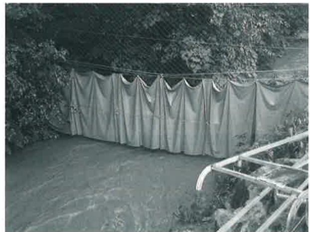
写真-1 シート目隠し施工
