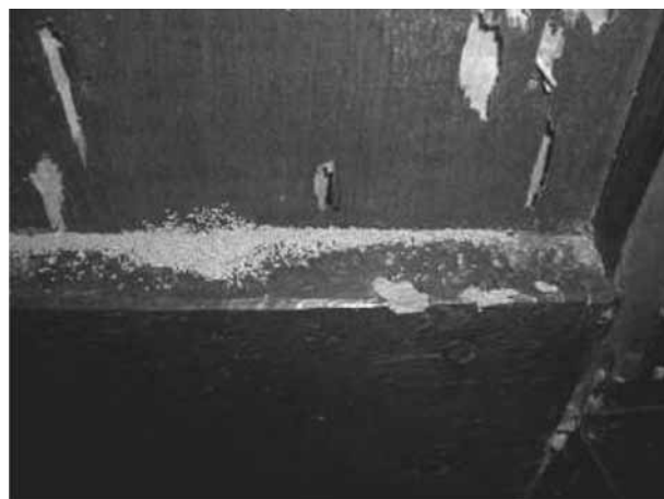
写真-3 ダイコクシロアリ属による被害例 (周囲の顆粒が糞)
