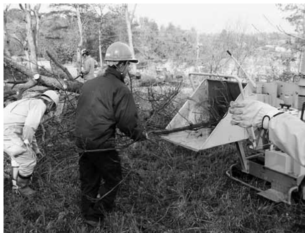
写真-2 チッパーの使用状況について
