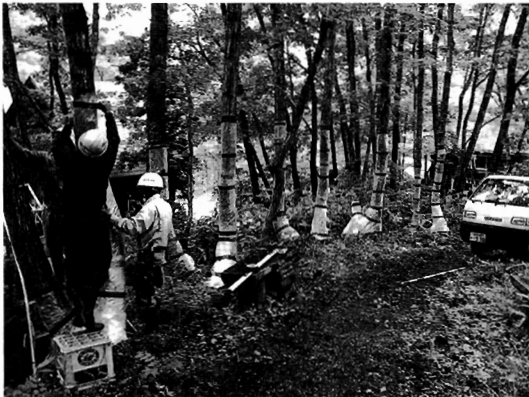
写真-3 ビニール被覆の状況
