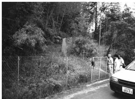
日田市伏木地区の獣害防止柵 (H=1.5m)
