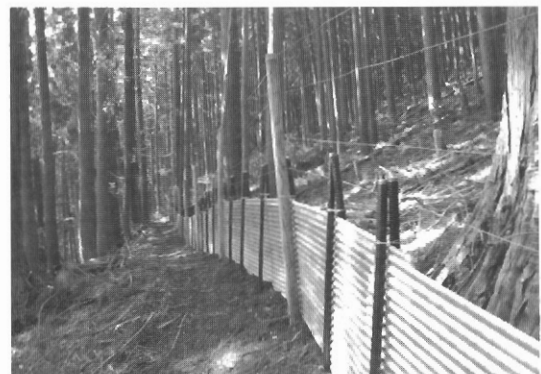
写真-1 侵入防止柵の設置
