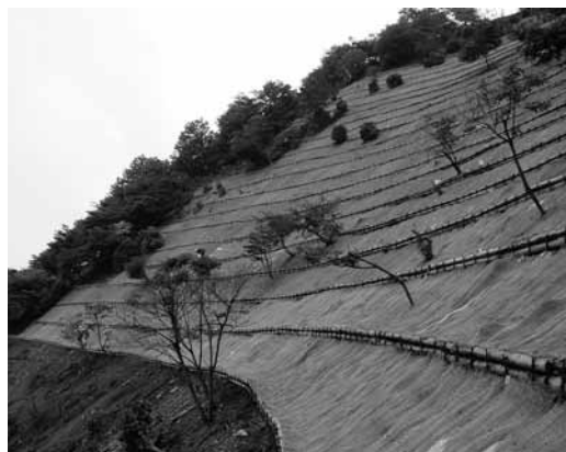
(治山工事による復旧)
