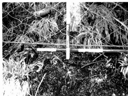
写真-3 網と固定器具がはずれた防護柵。シカは潜り抜けてくるので修理が必要。
