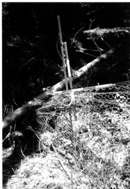
写真-5 倒木によって破損した防護柵。写真は網が破損しているのみであるが、支柱もろとも倒壊する場合もある。破損場所はシカの通路となるので修理が必要。
