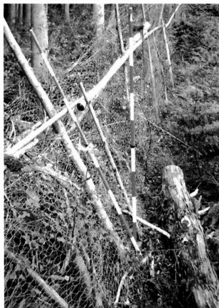
写真-6 木製の支柱が腐朽して傾いた防護柵。放置するとシカの通路となるので修理が必要。
