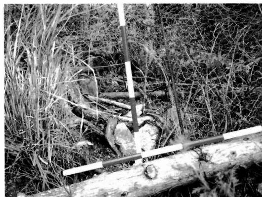
写真-4 網と地面に大きな隙間が生じた防護柵。一度生じた隙間はシカの通路となるので修理が必要。
