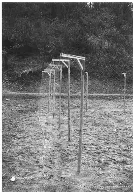
写真-2 ナイロン網柵B(間伐材支柱)
