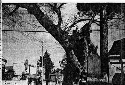
幹折れからの腐朽
