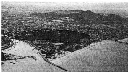
志島ヶ原の全景
