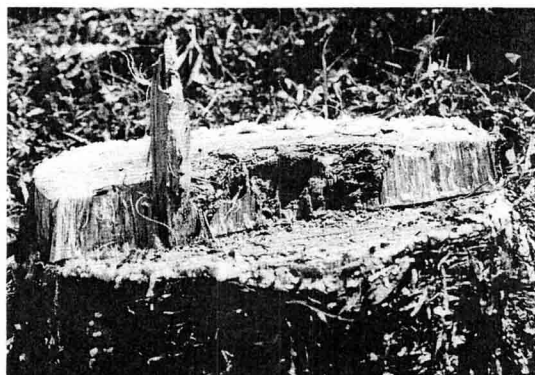
写真-6 フープバインに認められた腐朽病害
