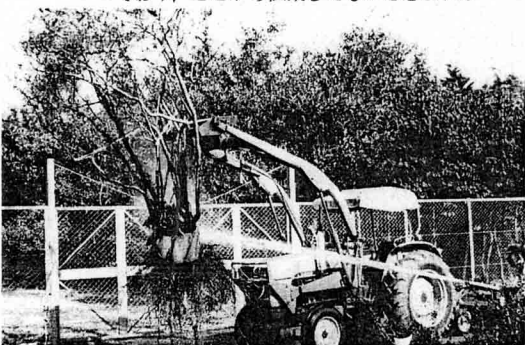
写真-5 高圧噴射器で土落し
