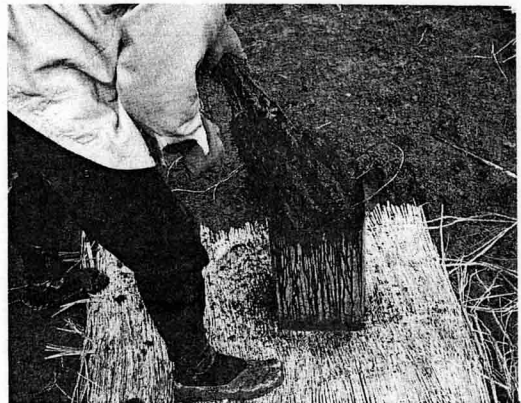
写真-1 浸漬処理の状況
