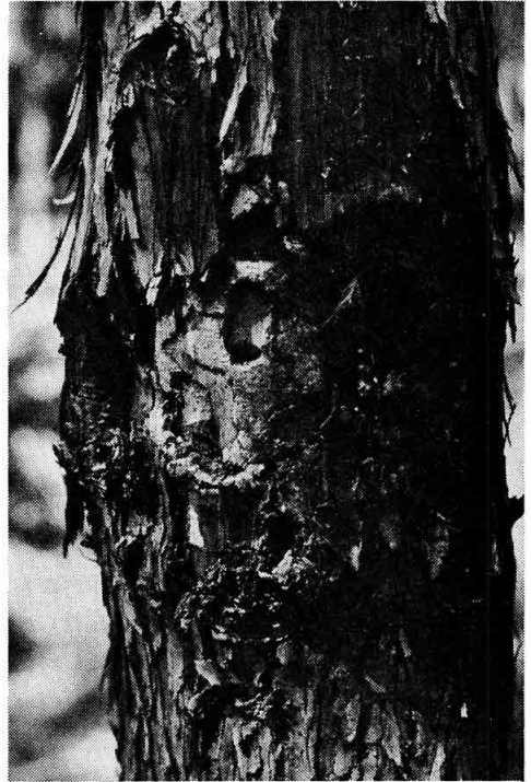
写真-3 スギカミキリの脱出孔 (栃木市)
