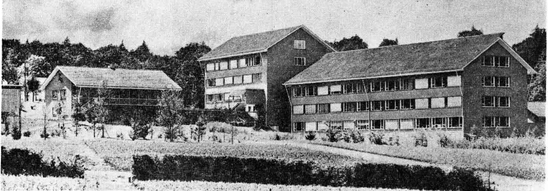
チューリッヒ、ビルメンドルフにあるスイス林業試験場
